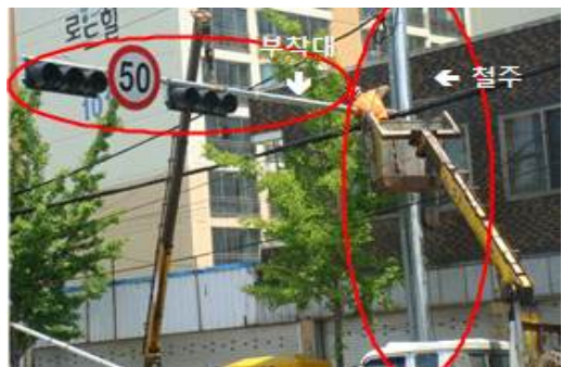
< 신호등 철주 및 부착대 시공 >
